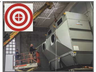
7月↑ブルザイの新BAGHOUSE
